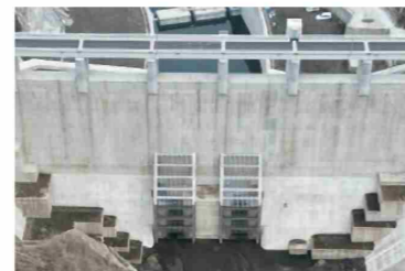
玉来ダム洪水吐き・流木止めスクリーン
