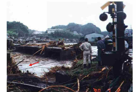
平成2年7月出水の状況 (玉来川 常盤橋付近)
