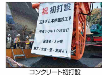
コンクリート初打設
