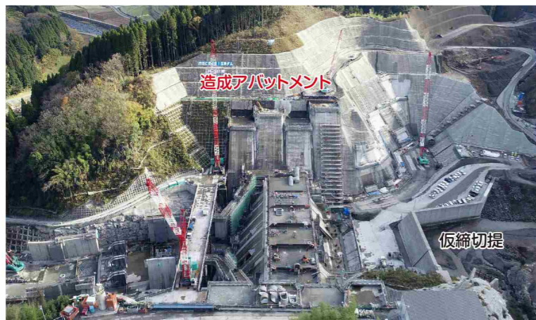
コンクリート打設中の玉来ダム
