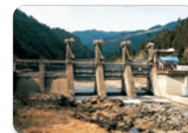
下赤逆調整池ダムと下赤発電所
