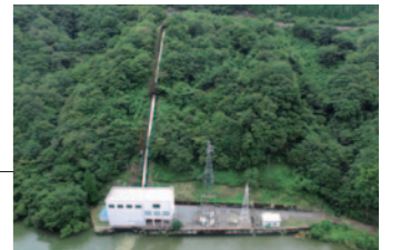
芹川第一発電所
