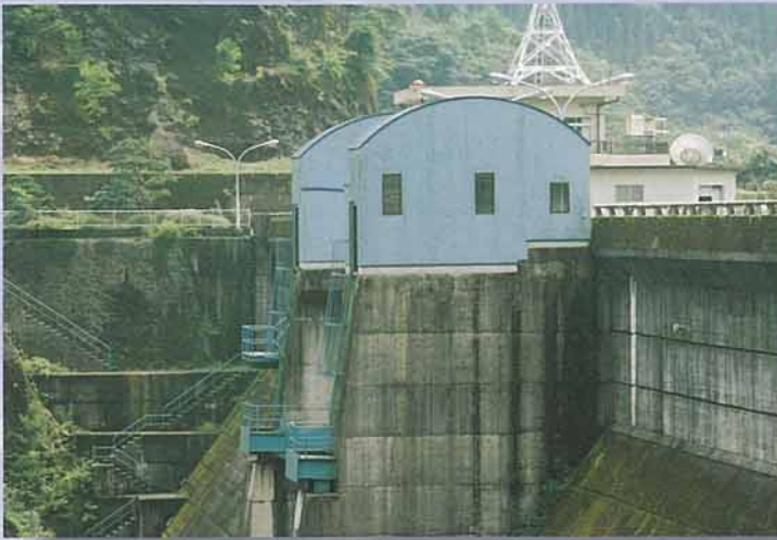
クレストゲート操作室
