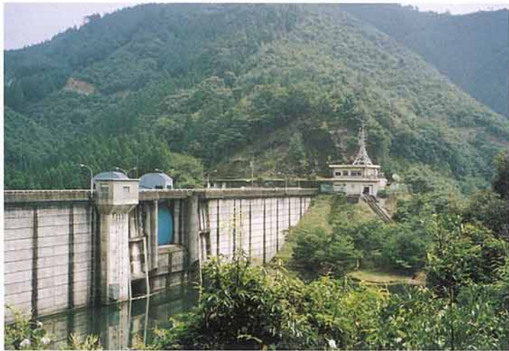
上流左岸からダムを望む
