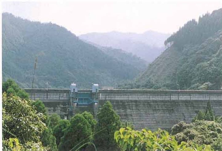
ダム下流からダム正面を望む
