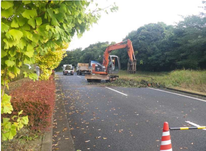
(道路啓開訓練)
