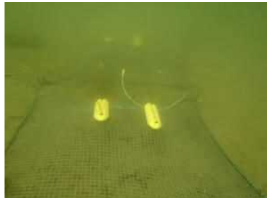
写真1 被覆網の設置状況（2019年6月の観音崎地先）
