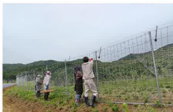
柵設置作業（豊後大野市）
