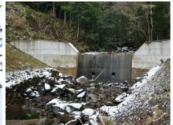
土砂を捕捉した治山ダム
