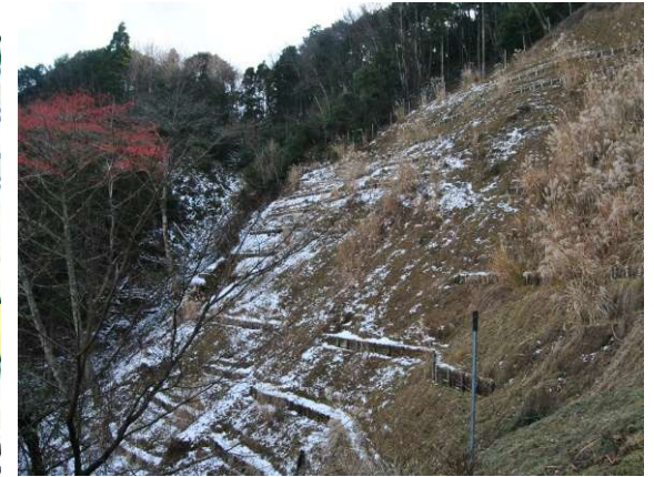
土砂を捕捉した治山ダム
