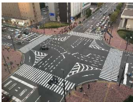
昭和通り交差点歩道橋撤去
