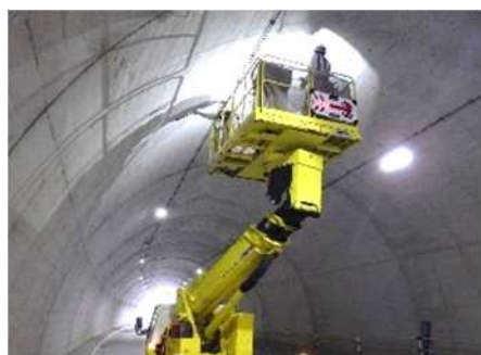
（従前）目視検査
