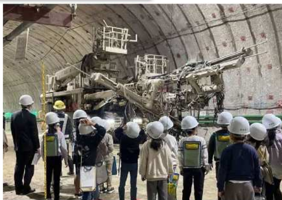
トンネル工事現場の見学
