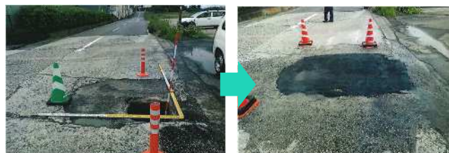
陥没した舗装の補修
