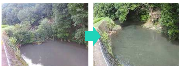
河川内支障流木撤去
