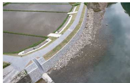
景観に配慮した河川護岸（山国川）
