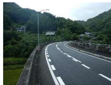
国道387号（宇佐市） ドットラインによる速度抑制対策
