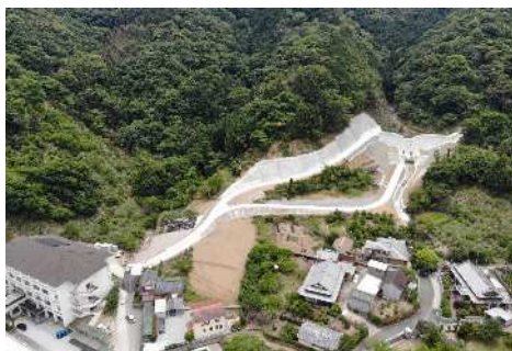
通常砂防事業 井無田川（津久見市）
