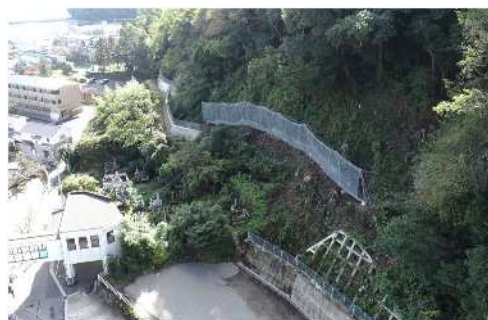
急傾斜地崩壊対策事業 新町地区（日出町）
