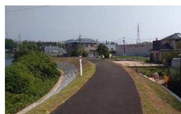
堤防天端の舗装
