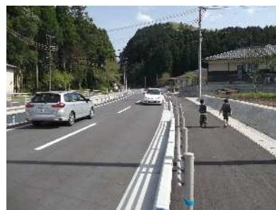
朝田日田線（日田市）歩道整備
