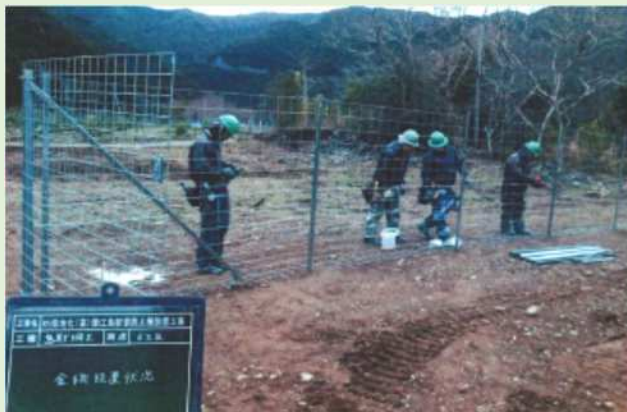
柵設置作業状況
