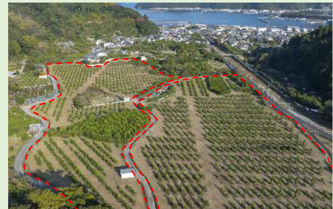
柵設置状況 (赤破線)
