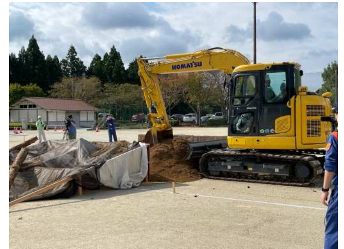
建設業協会による土砂・瓦礫撤去作業
