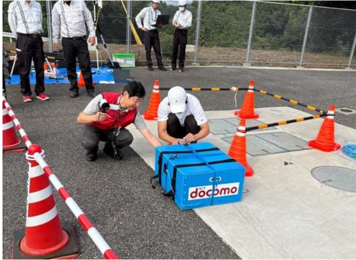
スターリンクの設置①
