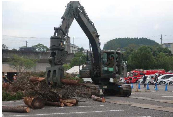
陸上自衛隊による道路啓開（倒木撤去）
