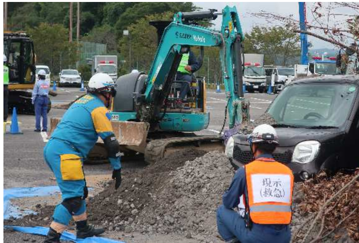
県警と建設業協会の連携した車両周辺の土砂撤去
