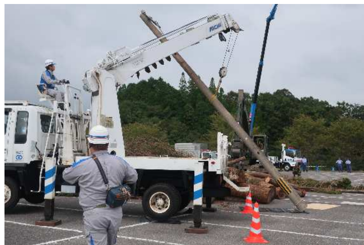
九州電力送配電による倒壊電柱の撤去
