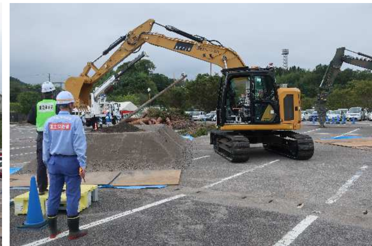
建設業協会、九州地方整備局による道路啓開（土砂撤去）
