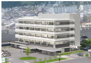
【写真】 別府総合庁舎 (R7年度完成予定) ZEB Ready 認証を取得
