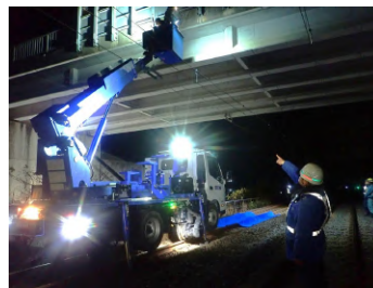
【写真】 跨線橋の点検 (地域一括発注)
