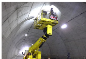
【←写真】 高所作業車を用いた 作業員による近接目視
