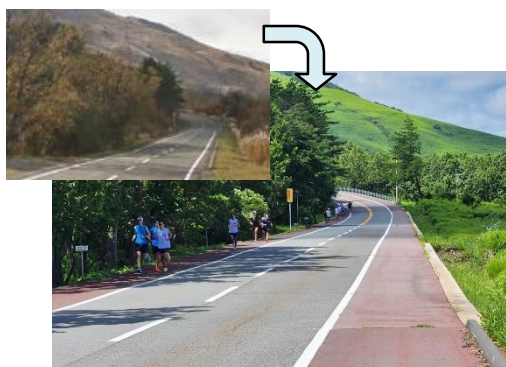
路肩拡幅による歩行者通行空間の創出（別府一の宮線：九重町）
