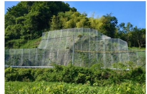
落石防護網の設置
