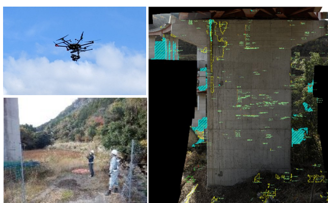
ドローン撮影を用いた橋梁点検
