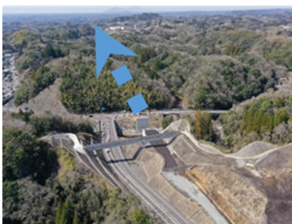
整備が進む竹田阿蘇道路 (竹田 IC 付近)
