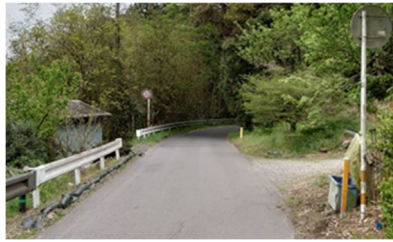
幅員が狭く見通しが悪い道路 (別府山香線:日出町)
