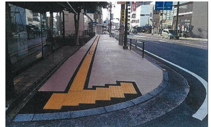
視覚障害者用誘導標示の設置 (日田玖珠線:日田市)
