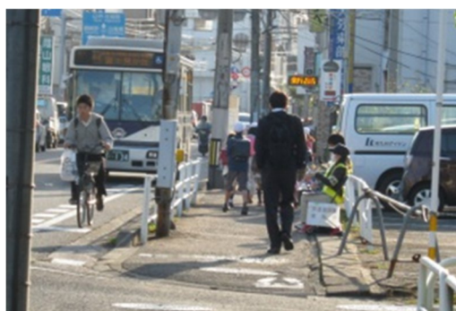
自転車通行空間が整備されていない道路
