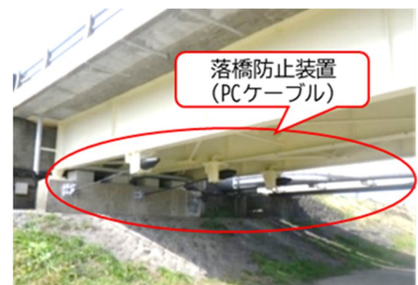
落橋防止装置の設置
