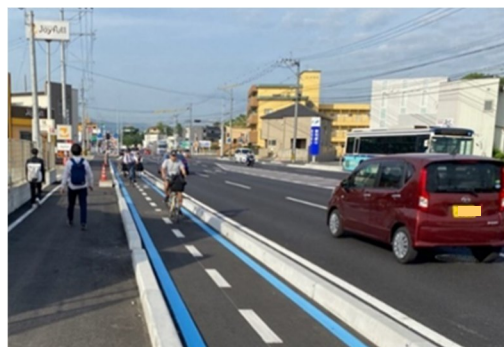
歩道・自転車道の整備状況
