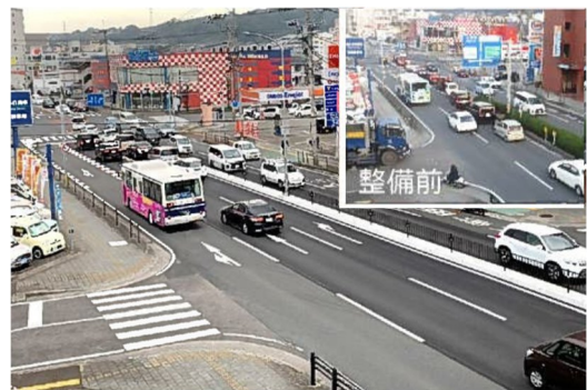
右折レーンの延伸による渋滞対策の実施 (国道197号:大分市)
