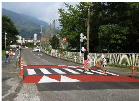
車道部をハンプ構造としたスムーズ横断歩道 (別府市)
