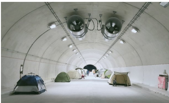
開通前トンネルでのトンネルキャンプ開催による 道路の魅力発信(耶馬溪道路:中津市)
