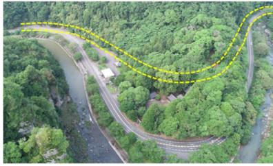
2次改築による線形不良の解消を図る区間 (豊後高田安岐線:豊後高田市、杵築市)
