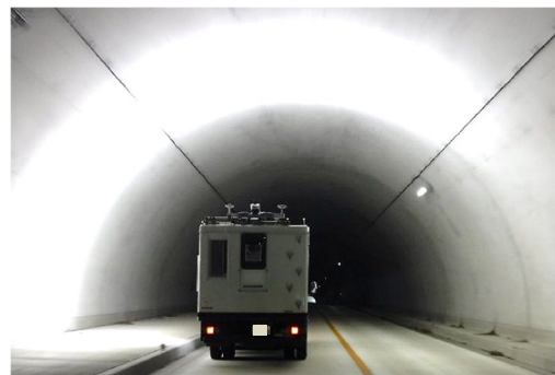
レーザーと高解像カメラを搭載した専用車両による走行型のトンネル点検
