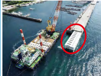
防波堤耐震工事 (流通・防災拠点：佐賀関漁港)
