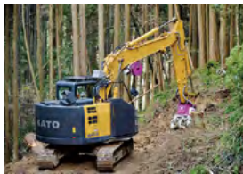
作業道整備 （バケット付きグラップル）
