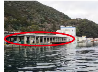
岸壁耐震工事 (流通・防災拠点：松浦漁港)
