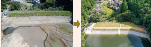
改修工事 (改修前)
