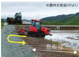
自動操舵に対応した基盤整備
