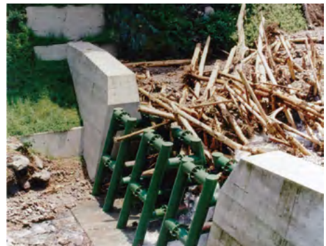
災害で発生した流木を防ぐ捕捉式ダム
