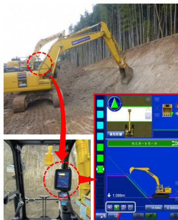
ICT建機での施工
