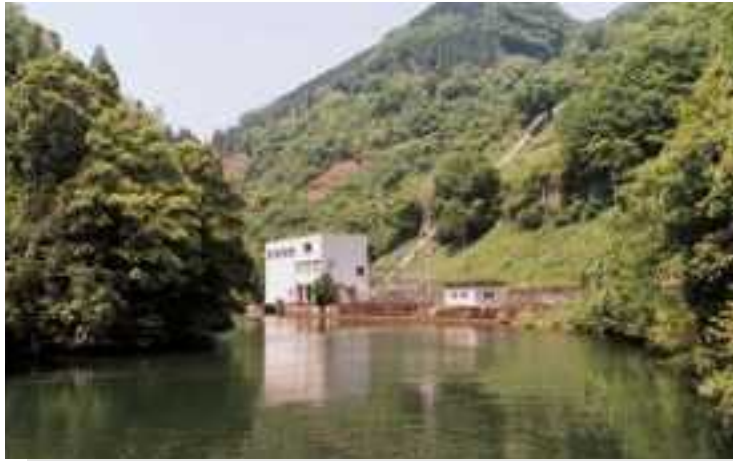
芹川第一発電所
