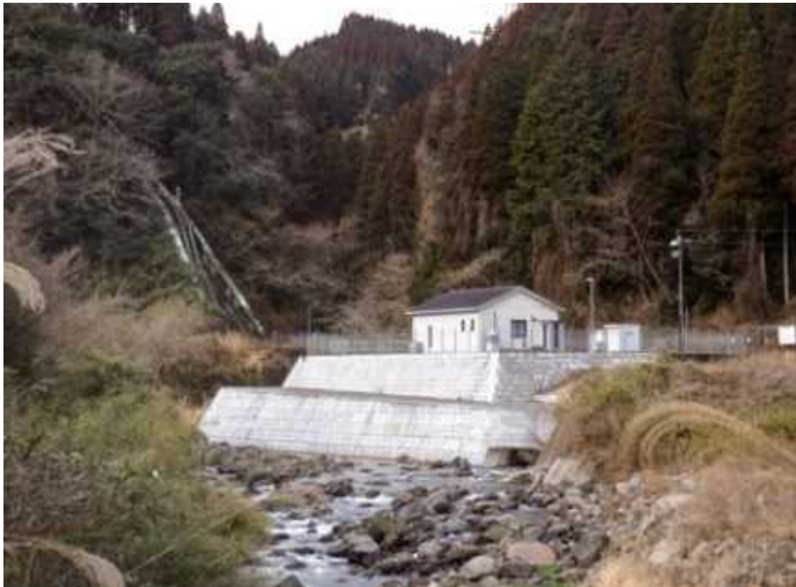
阿蘇野川発電所
