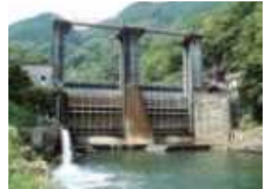
逆調整池ダム
