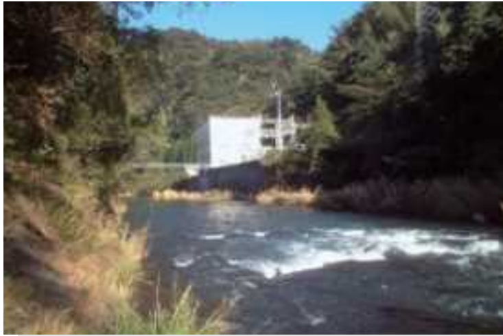
芹川第二発電所
