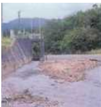
白水川取水堰
