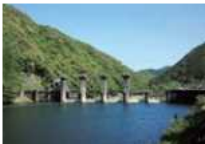
下赤逆調整池ダム
