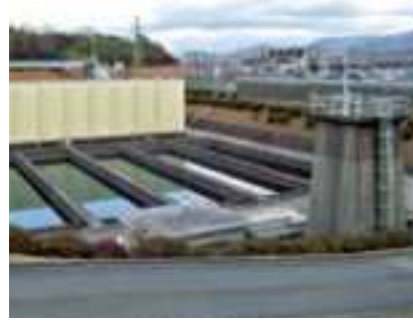
判田取水場 (中央が沈砂池)
