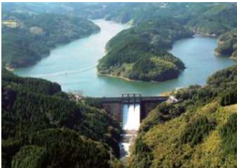
芦川ダム（左岸：竹田市、右岸：大分市）
