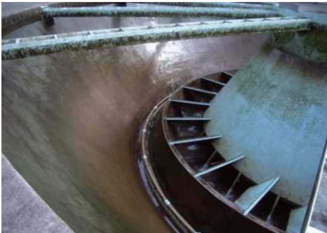
沈殿池清掃作業中
