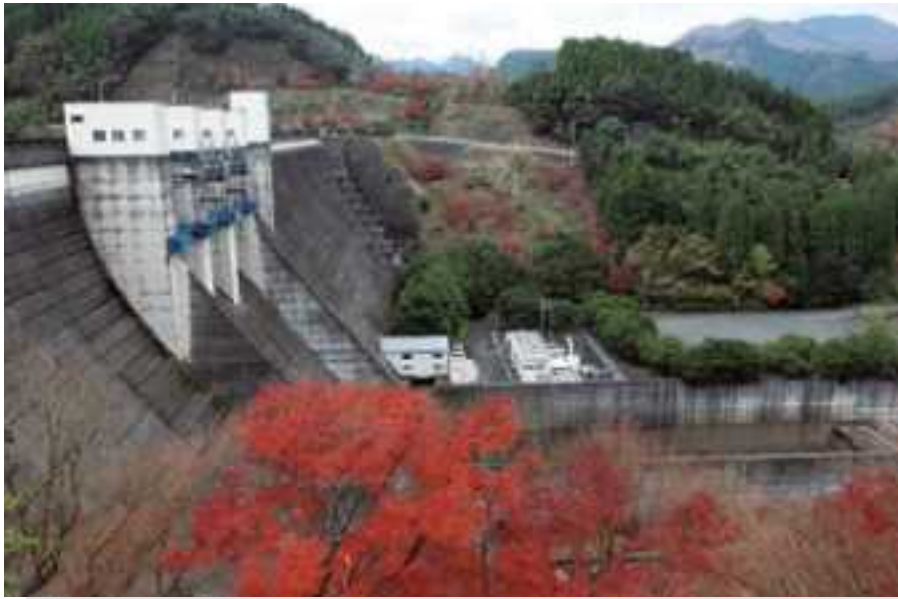
耶馬溪発電所
