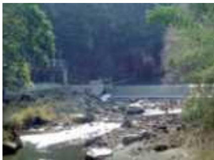
三重川取水堰
