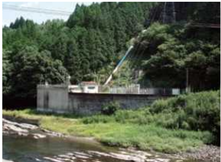
芹川第三発電所
