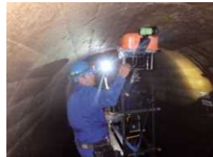
送水隧道点検中(火振志村線)
