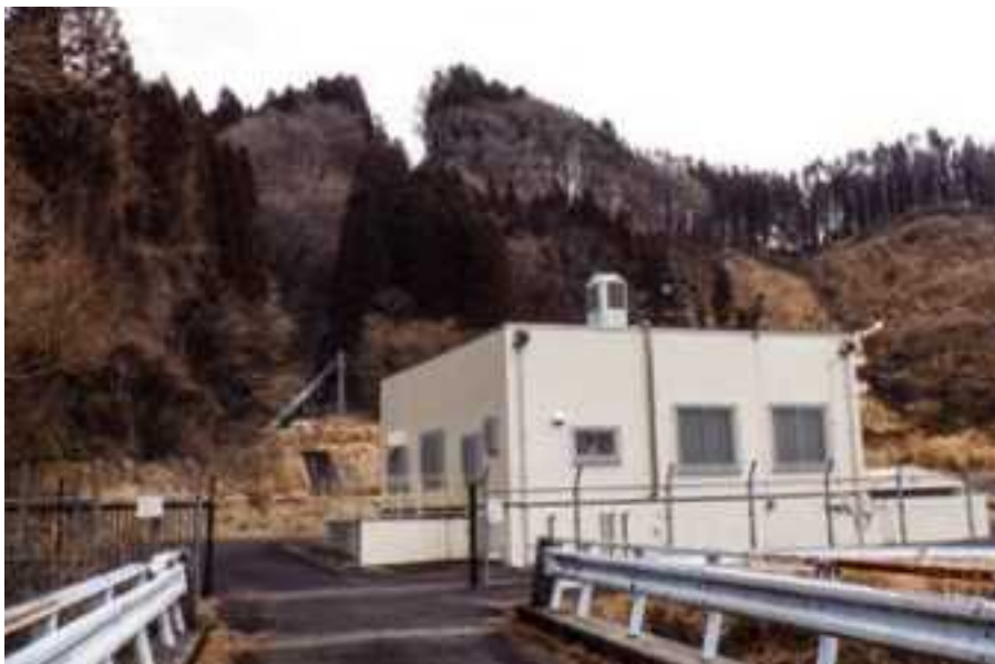
鳴子川発電所
