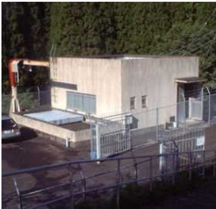
花合野川発電所
