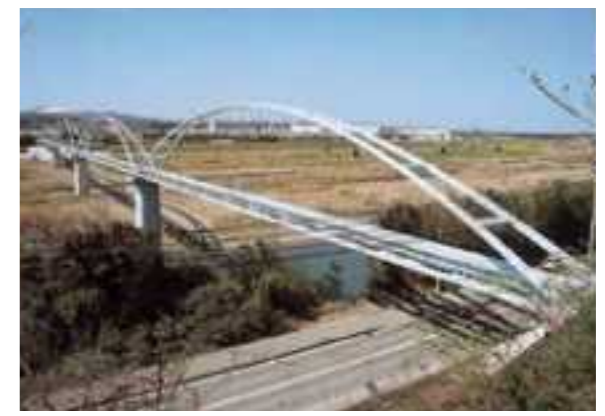
大野川松岡水管橋
