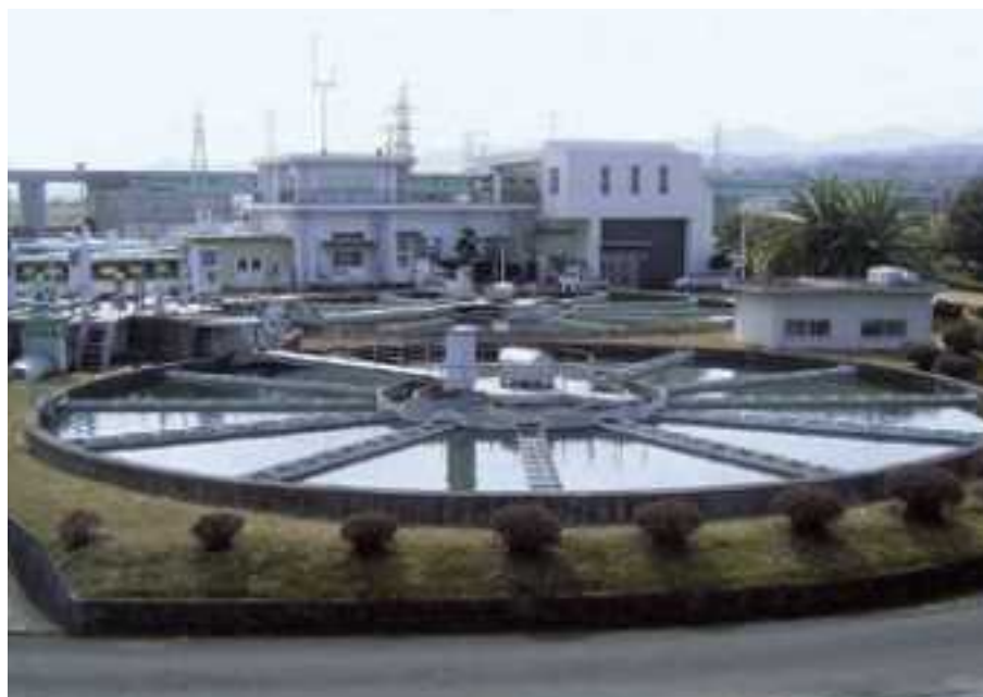
大津留浄水場（大分市）
