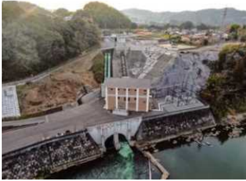
大野川発電所
