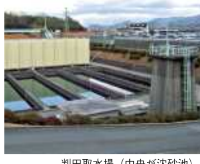
判田取水場 (中央が沈砂池)
