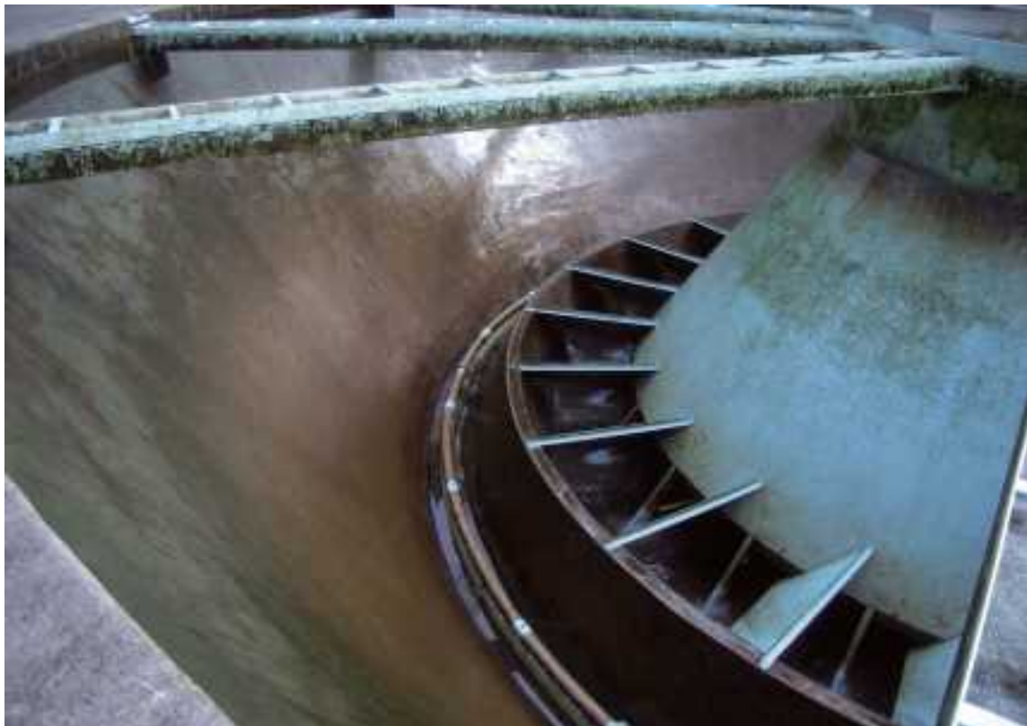
沈殿池清掃作業中
