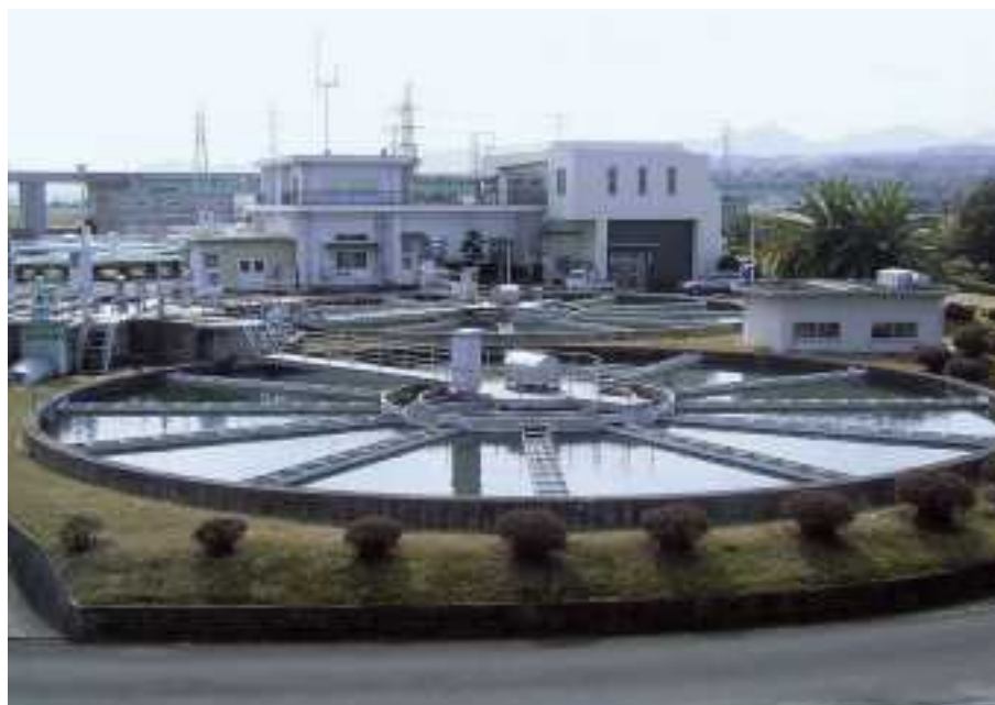
大津留浄水場（大分市）
