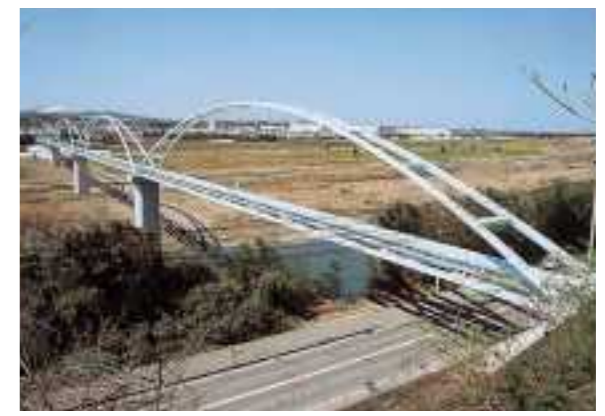
大野川松岡水管橋
