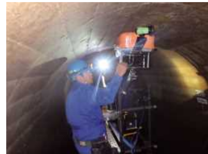
送水隧道点検中(火振志村線)
