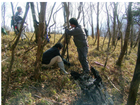
シカ防護柵の設置
