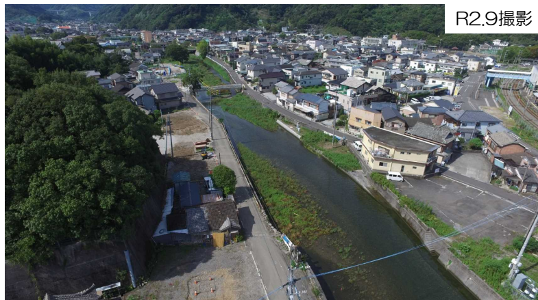
【下岩屋橋付近】
