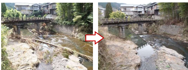
河川内支障流木撤去
