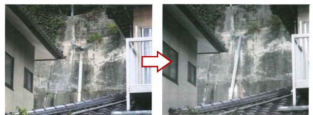
排水管の更新
