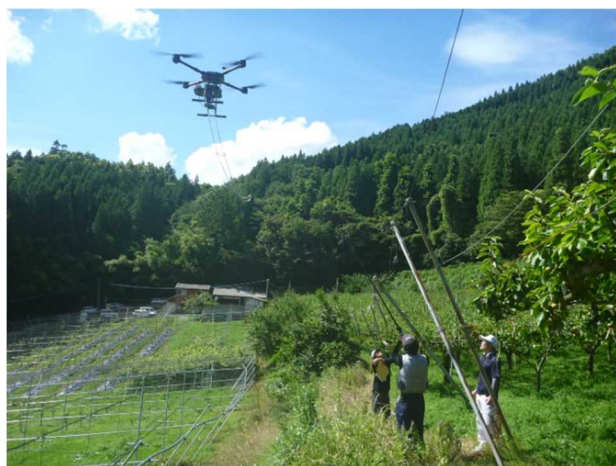
ドローンから下がるテグスを キャッチする作業員
