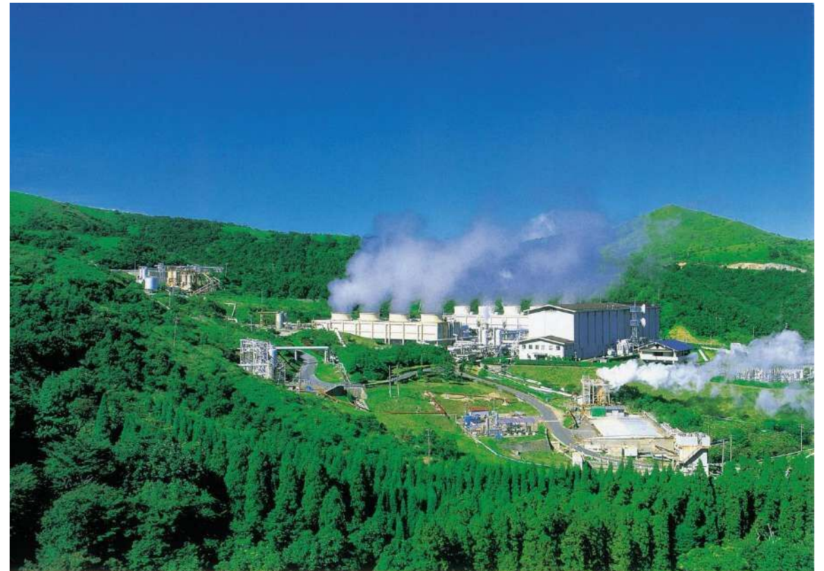
八丁原発電所(九重町)
