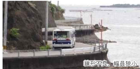
▲現道状況写真
