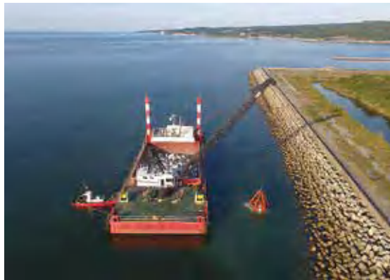
整備（調査）が進む西国東地区干拓堤防
