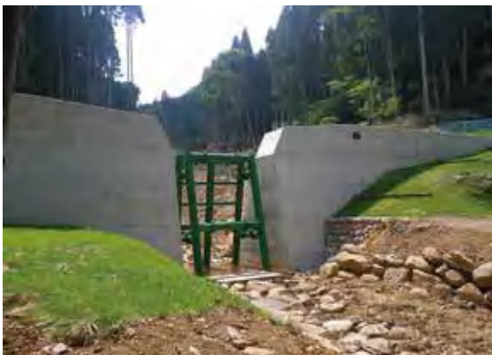
流木捕捉式治山ダム（スリットダム）の設置
