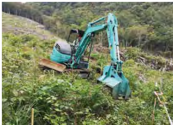
重機等を用いた下刈りの機械化
