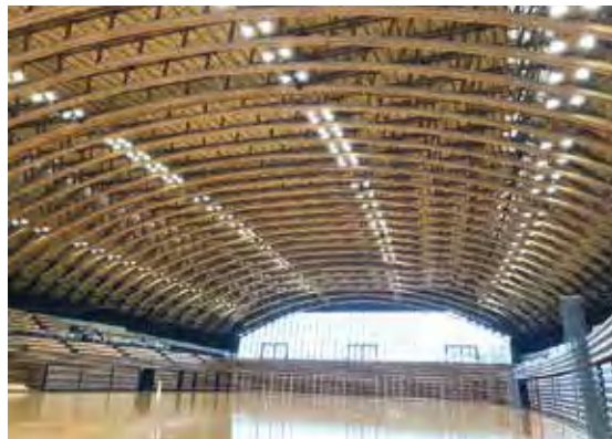
スギ無垢乾燥材を活用した大分県立武道スポーツセンター
