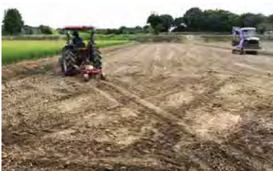
弾丸暗渠による排水対策
