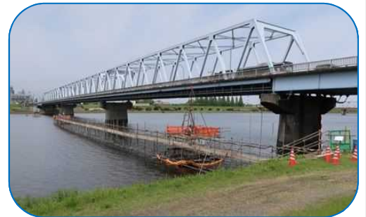
▲鶴崎橋地質調査（5月）
