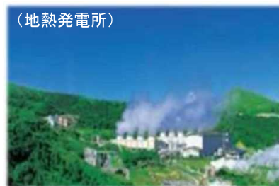
(地熱発電所) 地熱発電電力量 960千Mwh(令和1年度)
