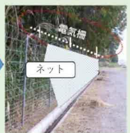
電気柵(柵上部)+ネット(柵の内側)
