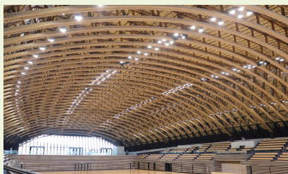
大分県立武道スポーツセンター（大分市） 木材を使った国内最大級のトラス構造
