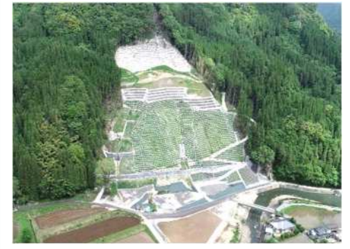
災害復旧工事
