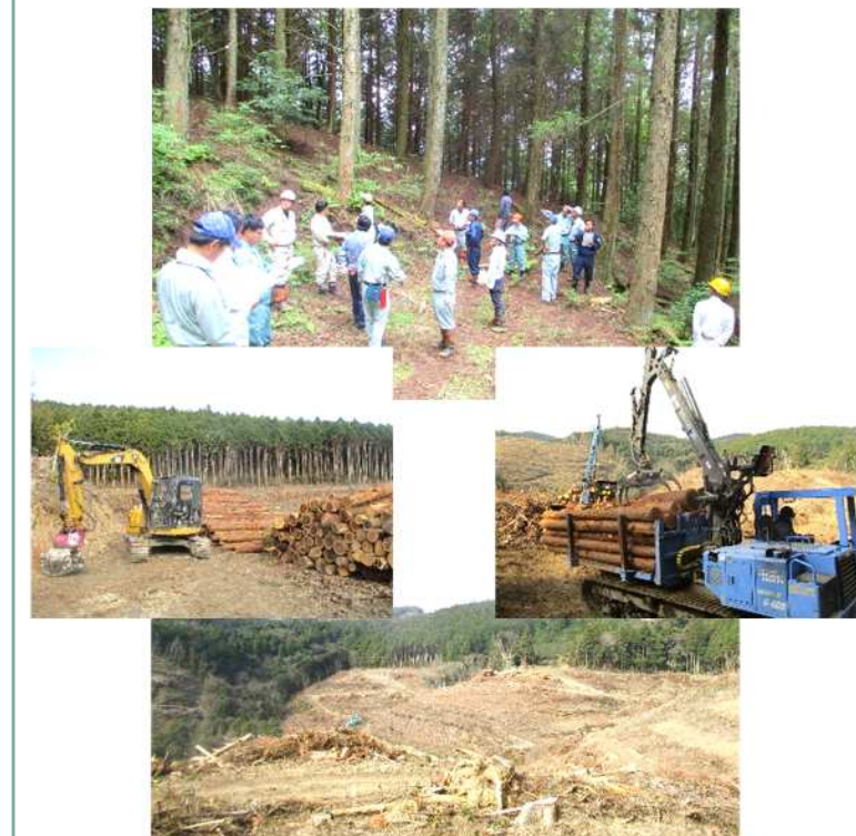
県有林の主伐地状況（植栽のための地拵え状況）
