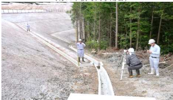
林地開発許可(太陽光発電施設)完了確認
