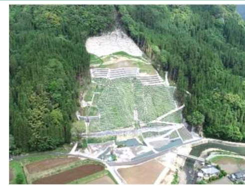
災害復旧工事
