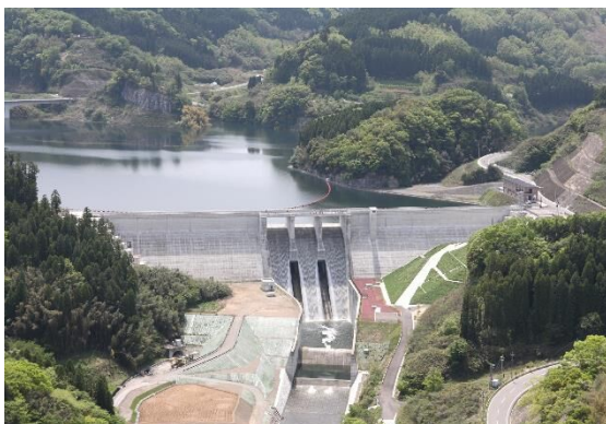
平成22年度に完成した稲葉ダム
