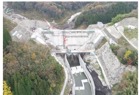
建設中の玉来ダム
