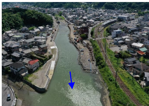
津久見川改修状況
