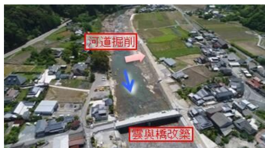
山国川改修状況
