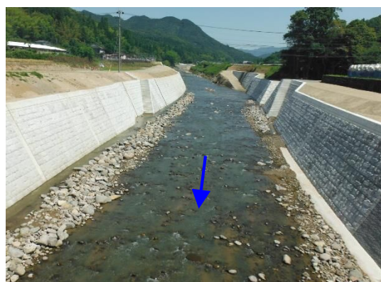
大肥川改修状況 (茶屋ノ瀬橋付近)
