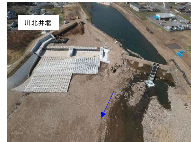
八坂川(整備中写真)
