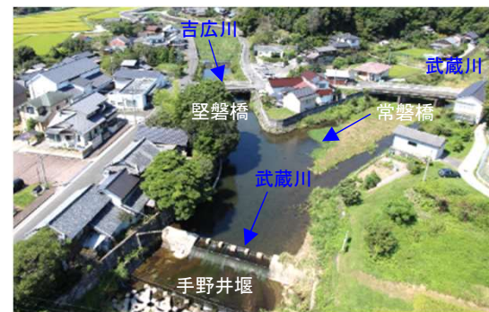
武蔵川(整備中状況写真)
