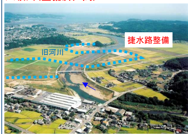
八坂川(整備済区間)
