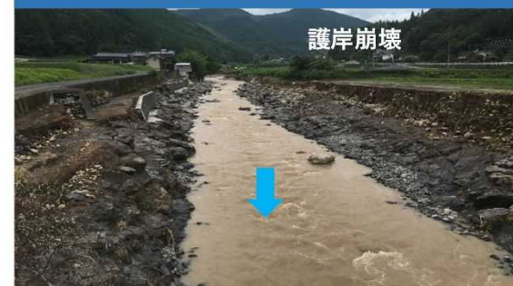
右岸崩壊による被害状況
