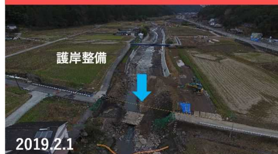
現在の状況（護岸整備）
