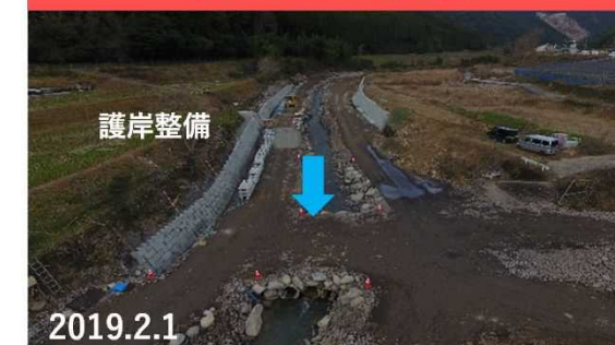
現在の状況（護岸整備）
