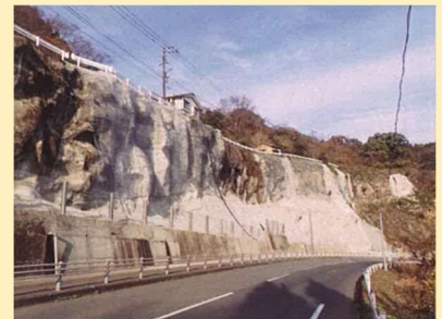
国道442号野津原工区（大分市）
