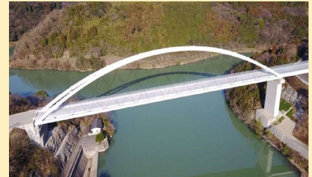
大田杵築線 溝井工区（別府市）
