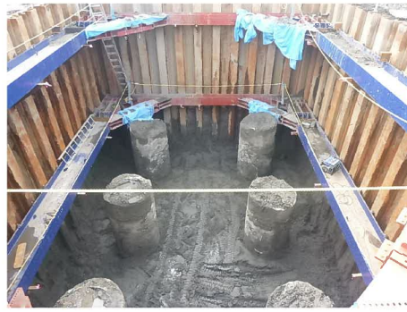
仮設土留め工 (切梁・鋼矢板設置状況)
