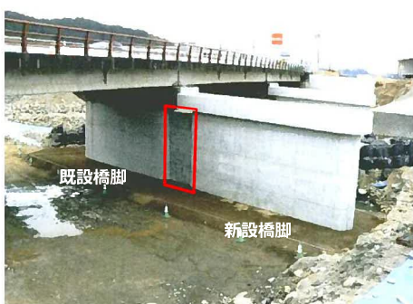
隔壁工 (設置状況)
