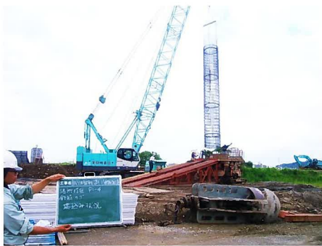
場所打杭工 (杭鉄筋吊込み状況)
