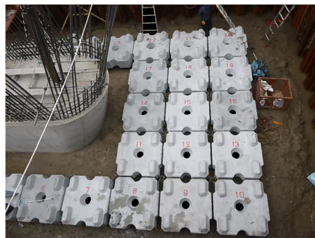
根固め工 (設置状況)
