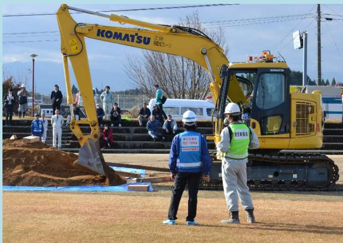
道路啓開訓練
