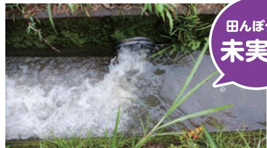
田んぼダム 未実施 ほ場からの排水 (排水量が多い)
