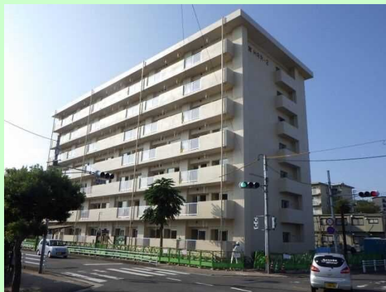
建替後（工事中）
