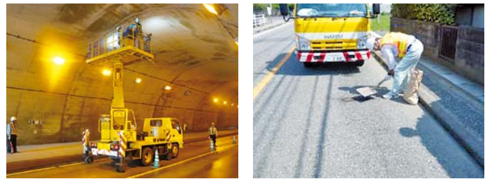
トンネルの詳細点検
