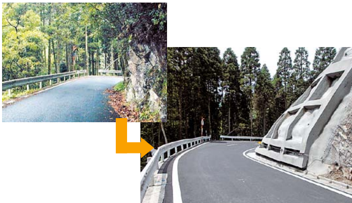
線形改良等による局所改善 (菅原戸畑線：玳珠町)
