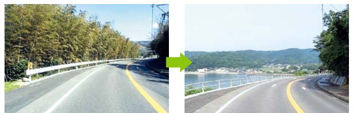
眺望の支障となる樹木伐採、防護柵の更新 (国道213号：豊後高田市堅来)
