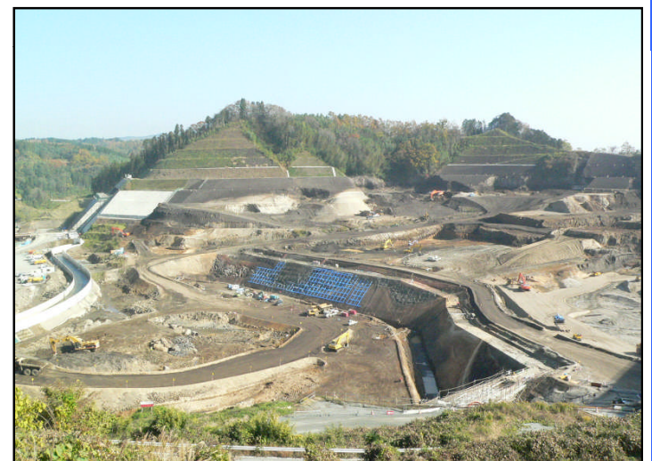
貯水池対策工事
