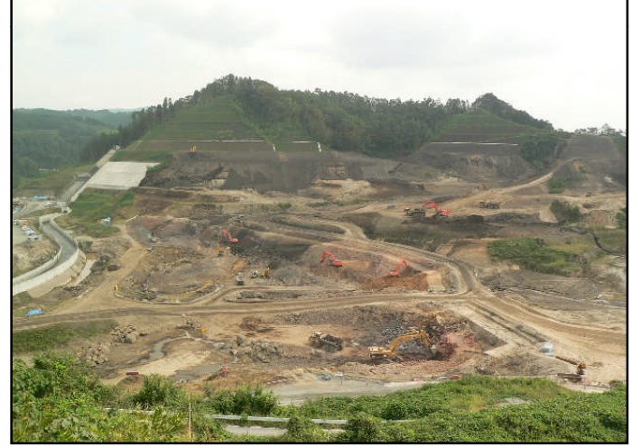
貯水池対策工事
