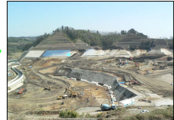
貯水池対策工事
