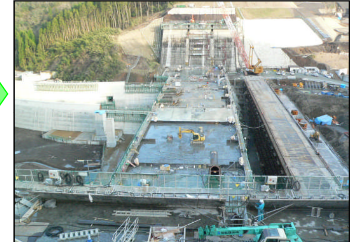
稲葉ダム本体工事
