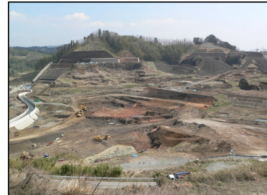
貯水池対策工事
