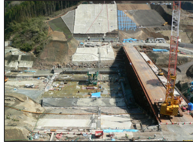
稲葉ダム本体工事
