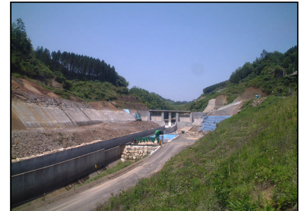
貯水池対策工事(上流仮締切付近)
