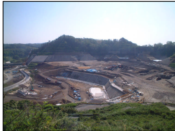
貯水池対策工事
