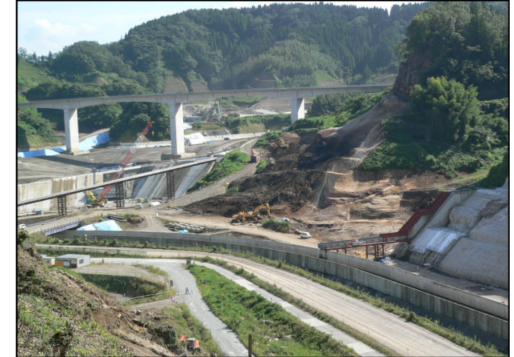
貯水池対策工事
