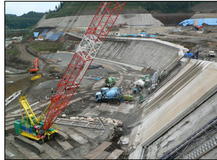
貯水池対策工事
