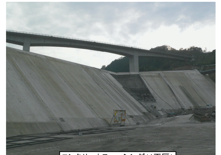
コンクリートフェーシング(1工区)
