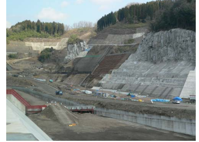
貯水池対策工事 撮影日：平成20年3月26日
