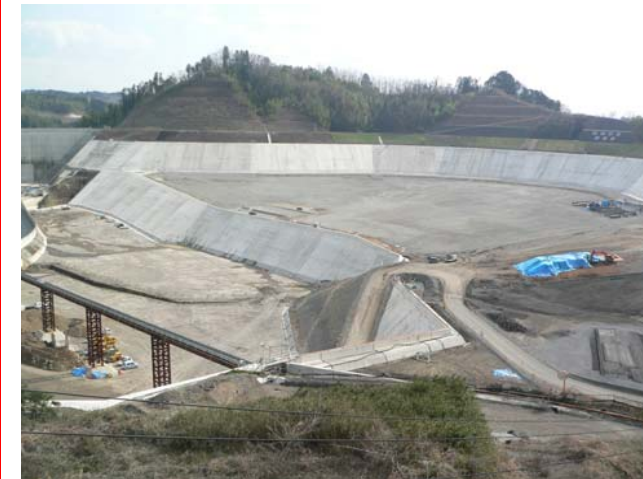
貯水池対策工事 撮影日：平成20年3月26日
