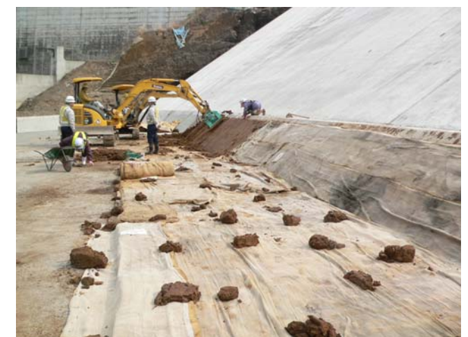
貯水池対策工事 撮影日：平成20年3月27日
