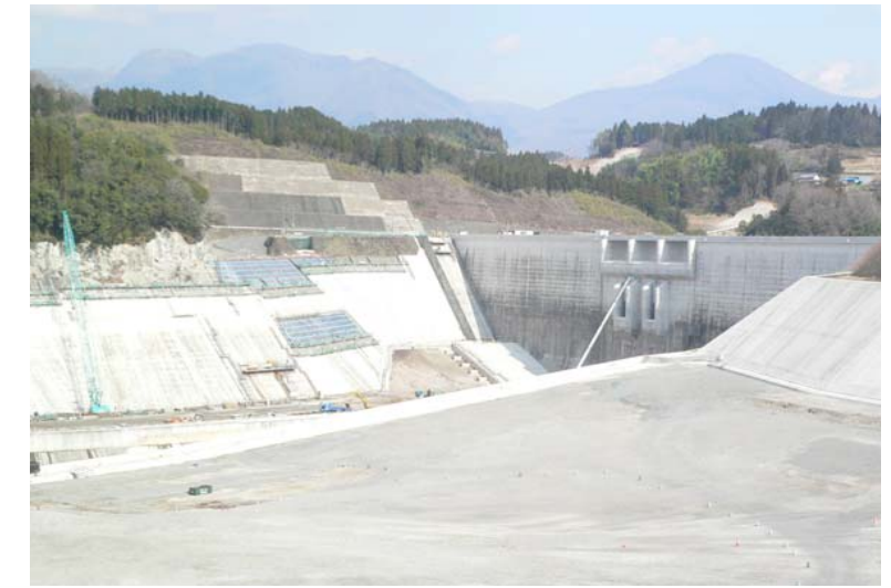
稲葉ダム本体工事 撮影日：平成20年3月26日
