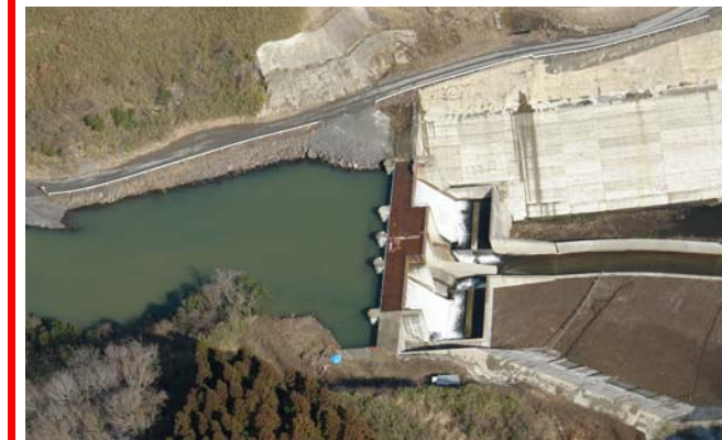
貯水池対策工事 撮影日：平成20年3月5日
