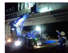
跨線橋の点検 (地域一括発注)
