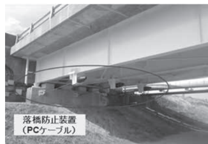
落橋防止装置の設置 (大分臼杵線 高田橋：大分市)
