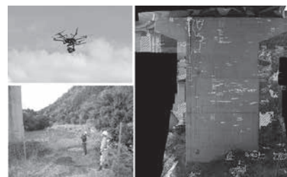
ドローン撮影を用いた橋梁点検
