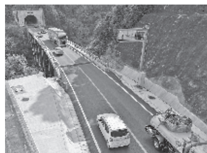
バイパス整備による線形不良の解消 (栃野西大山線：日田市)
